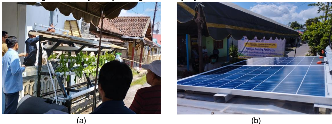
Gambar 4. (a) Proses perakitan panel surya pada proyek bersama, (b) Panel surya berpendingin water spray
