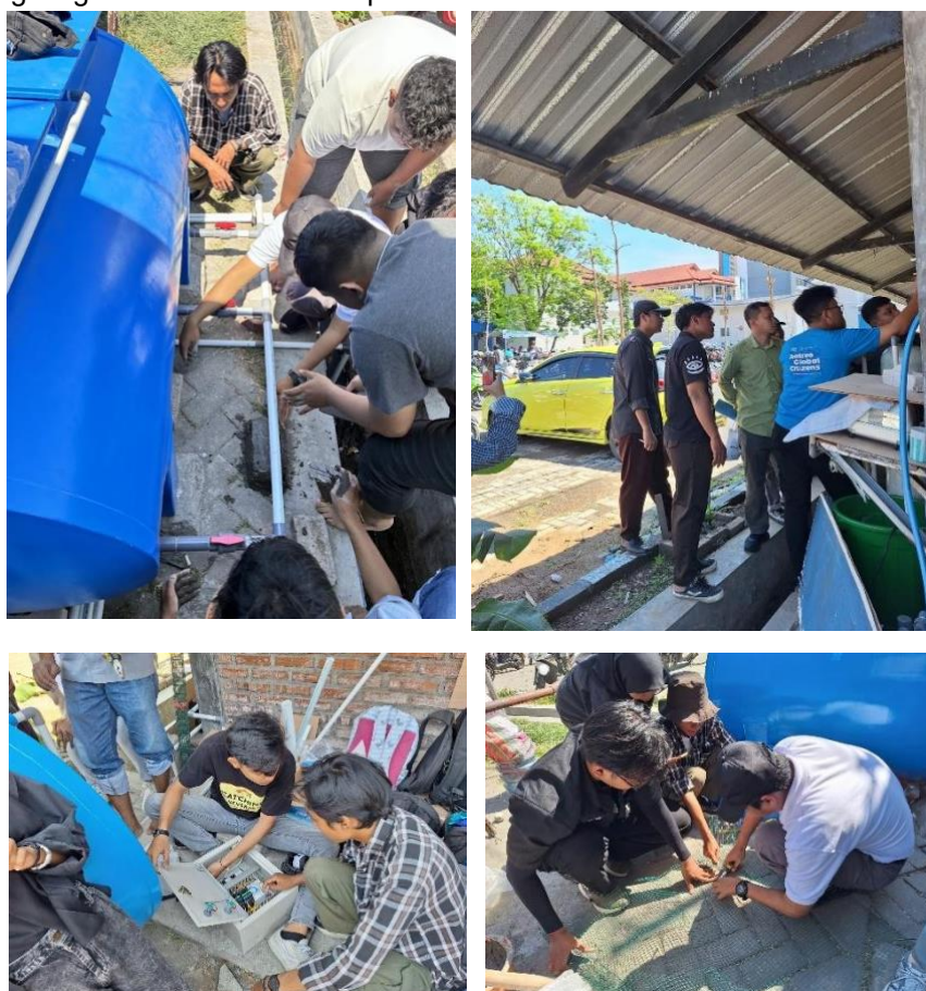
Gambar 3. Pemasangan Instalasi Pengelolaan Air Limbah (IPAL)
