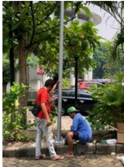
Gambar 3.1 Proses Instalasi Tiang PJU dan Unit Lampu di Jalur Akses Technopark Sumber: Dokumentasi Pribadi
