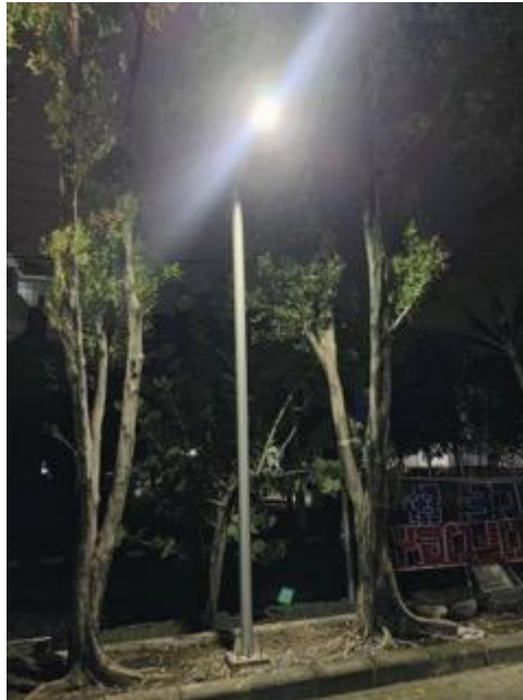
Gambar 4.2 Kondisi Lingkungan Sesudah Pemasangan Lampu Sumber: Dokumentasi Pribadi
