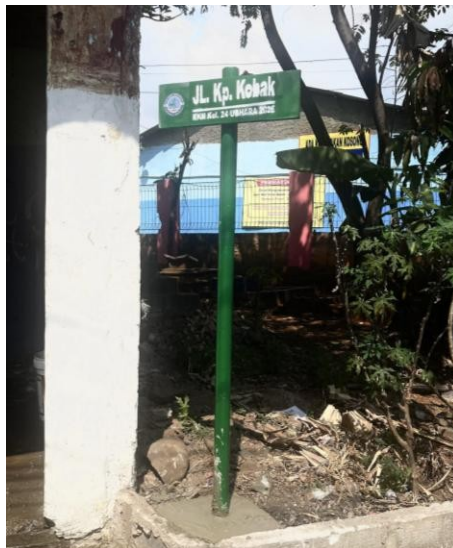
Gambar 7. Pemasangan Plang Penunjuk Jl. Kp.Kobak
